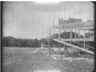
Construction de la villa Savoye, début d'une séquence panoramique
