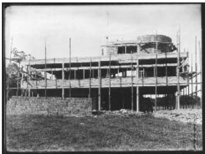
Façade nord-est en construction, été 1929 (FLC, L2-17-2)
