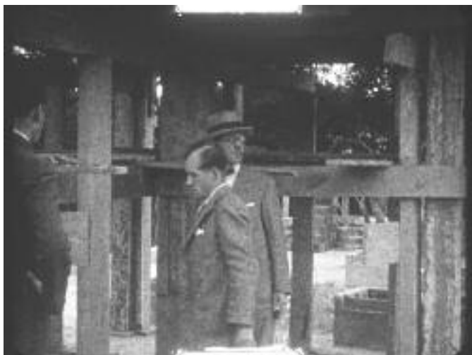
Photogramme de l'inspection du chantier de la villa Savoye
